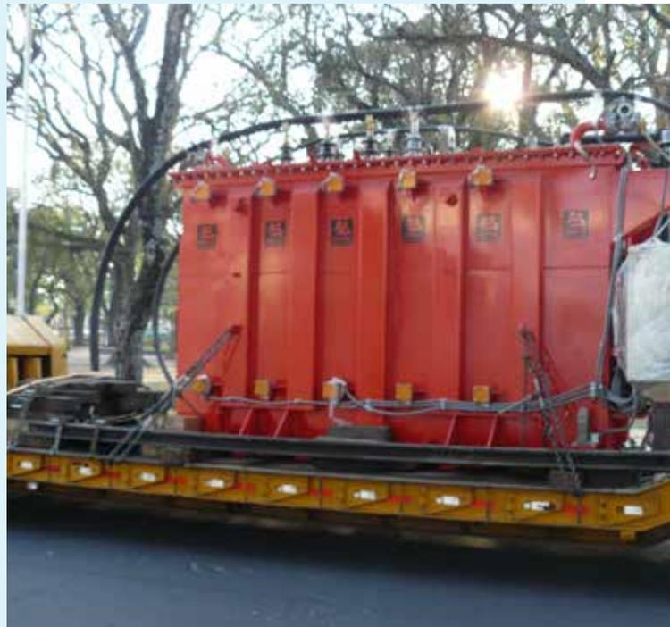
Nuevo transformador de 20 MVA para la ampliación del CD N°14 y ET de 33 / 13,2 kV.
