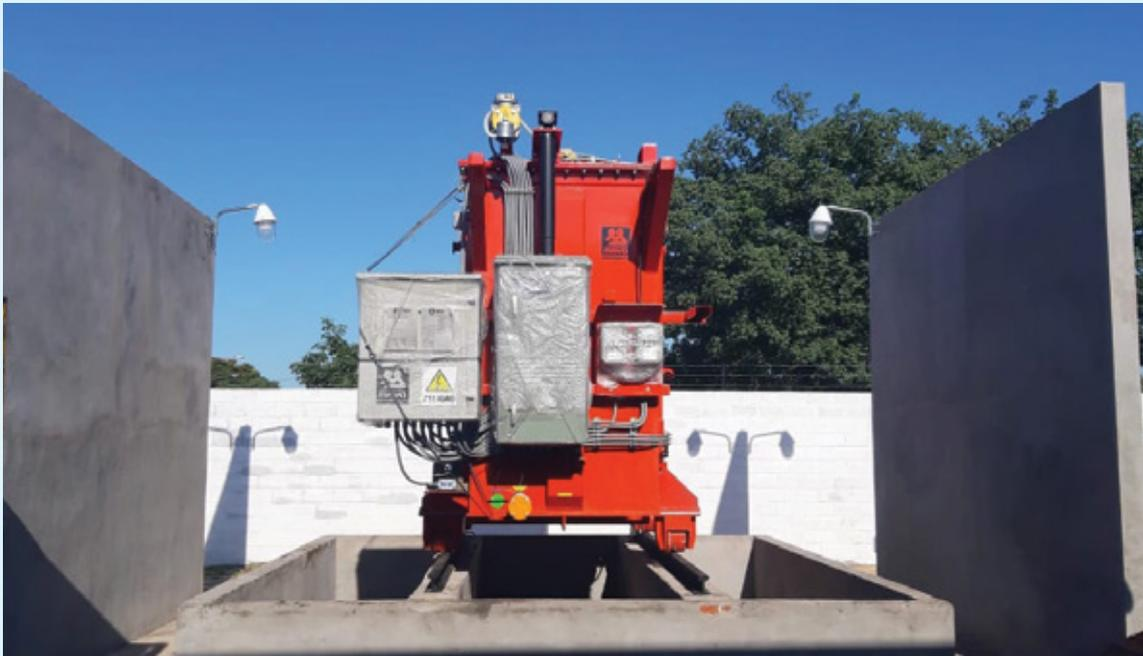
Transformador de rebaje de 33/13,2 kV - 20 MVA, con regulador bajo carga -15 / +5 %.
