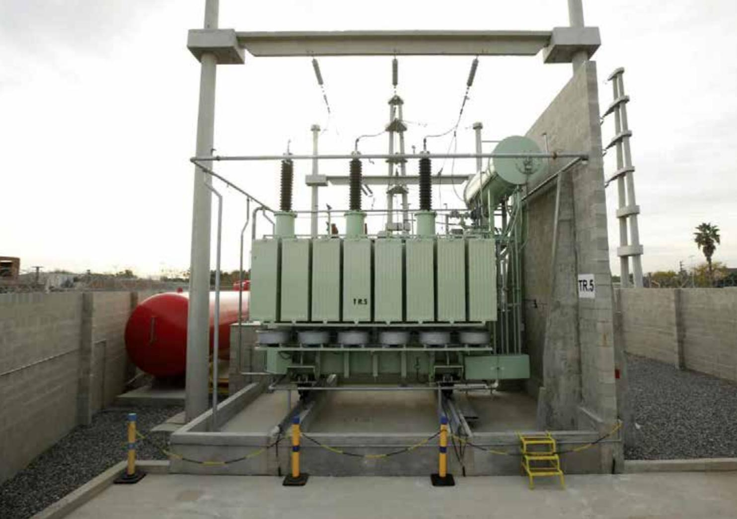
La nueva subestación Padre Novak tiene un transformador de 40 MVA.
