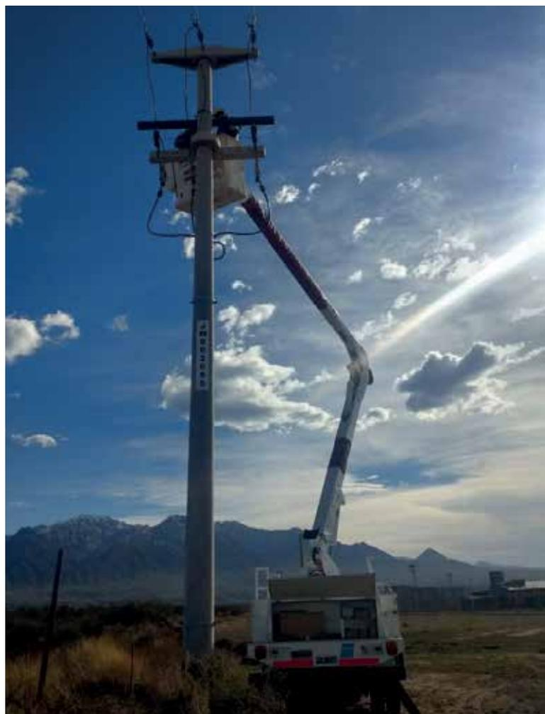
Se instalaron nuevas crucetas sintéticas sobre el vínculo del seccionador y una percha sobre el vínculo de retención.
